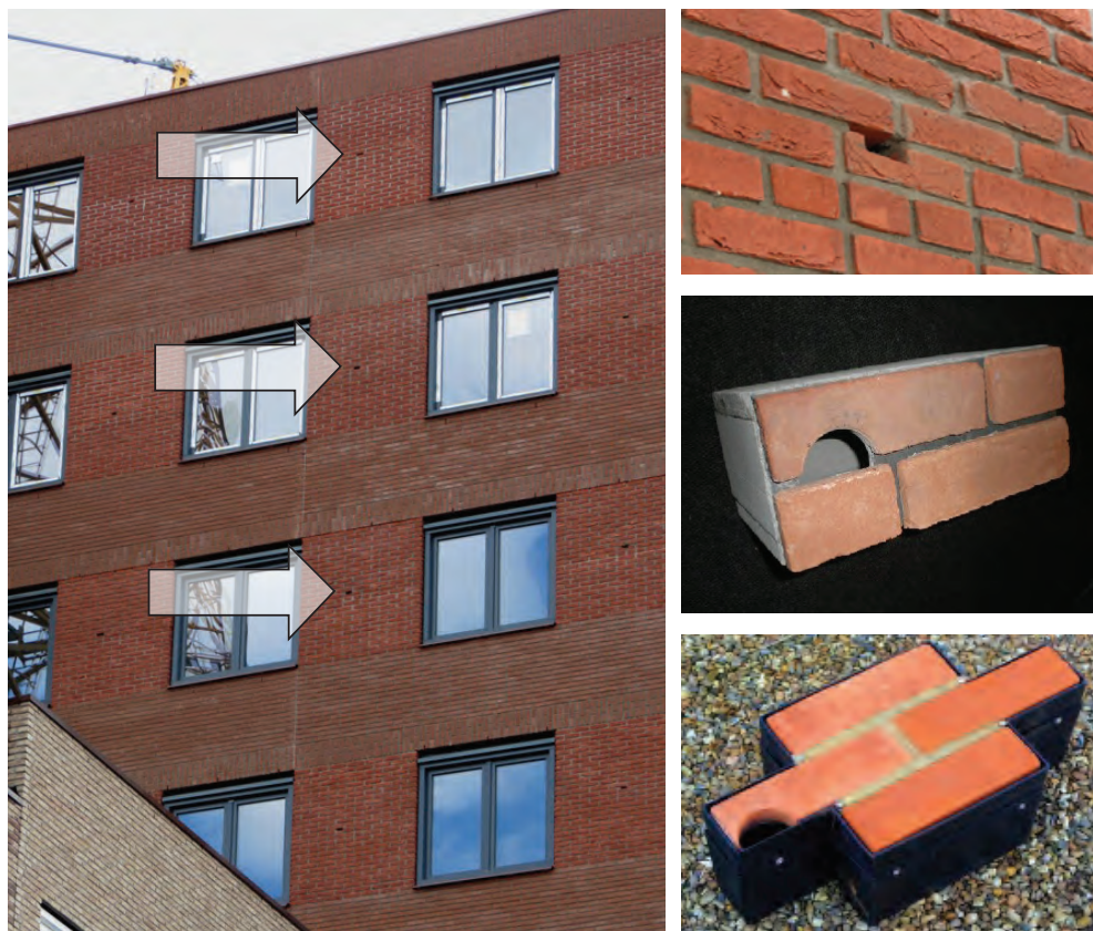
Fot. 115. Inne rodzaje prefabrykowanych elementów konstrukcyjnych stosowanych do tworzenia siedlisk w nowo powstających budowlach (JK, DN)
