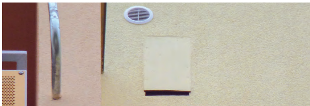
Fot. 111. Nie zawsze trzeba posiłkować się rozwiązaniami gotowymi. Ten schron dla nietoperzy powstał poprzez zamontowanie płyty z tworzywa sztucznego przykrywającej trzycentymetrową przestrzeń wyciętą w styropianie (DZ)
