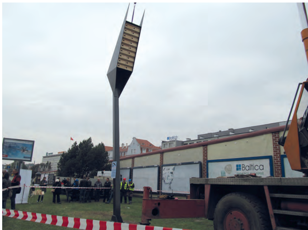
Fot. 117. Montaż wieży jerzykowej w Gdańsku (JT)
