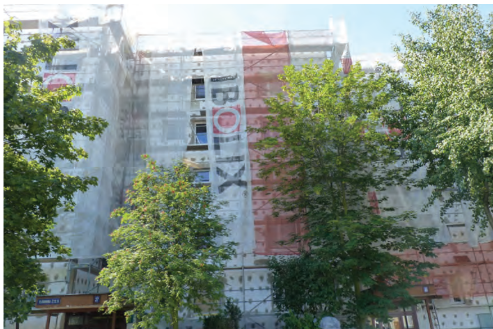
Fot. 21. Budynek wielkopłytowy w trakcie docieplenia (DZ)
