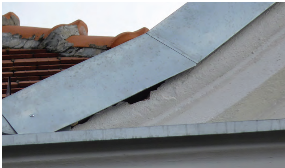
Fot. 99. Jedna z czterech szczelin pod obróbką blacharską krawędzi dachu, gdzie gniazdowały jerzyki. W trakcie renowacji budynku miejsca te pozostawiono nietknięte, dzięki czemu ptaki w kolejnym sezonie mogły bez problemu powrócić do swoich gniazd (DZ)
