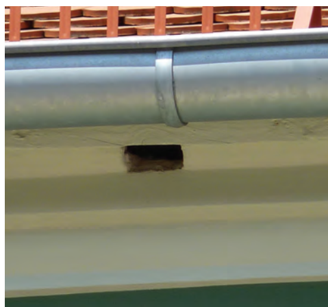
Fot. 100. W tej szczelinie pod krawędzią dachu Urzędu Miasta w Szczecinie gniazdowała para jerzyków. Po remoncie elewacji pozostawiono im swobodny dostęp do gniazda poprzez otwór o wysokości 3,5 cm i szerokości 6 cm (DZ)
