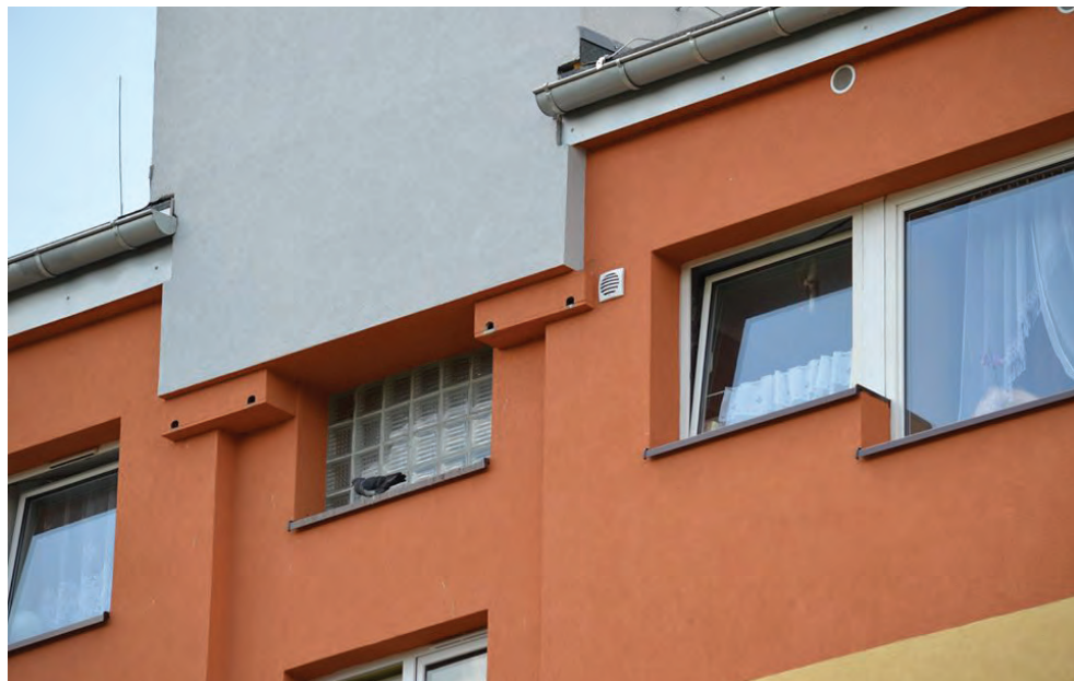
Fot. 105. Skrzynki drewniane zamontowane w warstwie ociepliny i otynkowane (AT)
