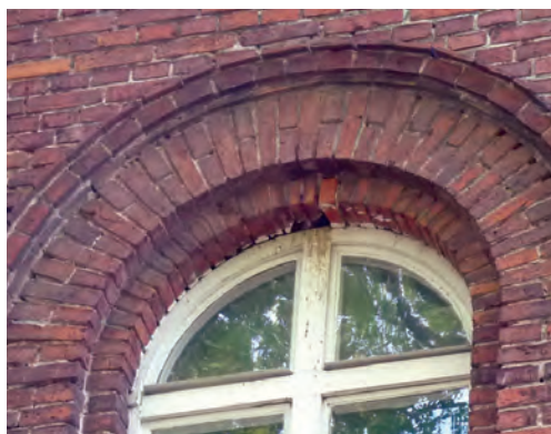
Fot. 47. Niewielki ubytek u szczytu okna zapewnia wystarczającą przestrzeń dla jerzyków do odbicia łęgów. Odchody poniżej prawdopodobnie zostały pozostawione przez przebywające tam wcześniej wróble (DZ)
