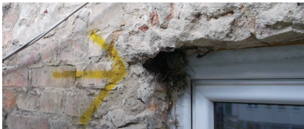
Fot. 64. Na tej fotografii widać materiał gniazdowy naniesiony przez wróbli do szczeliny w rogu okna (DZ)
