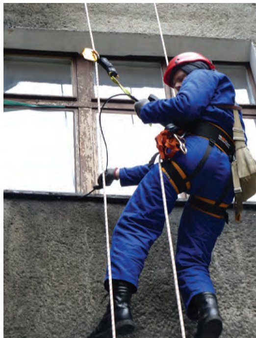
Fot. 27. W tym wypadku inspekcja parapetu byłaby niemożliwa bez wybijania szyb. Zastosowanie technik alpinistycznych pozwoliło ustalić czy jest on siedliskiem ptaków lub nietoperzy (DZ)
