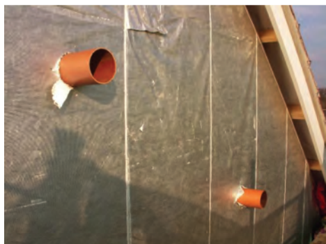
Fot. 114. Niemal niewidoczna skrzynka wewnętrzna chroniona przed warunkami atmosferycznymi może być wykonana z cienkiej i taniej sklejkki. Do jej wnętrza prowadzi chropowata, ułatwiająca zwierzętom dostawanie się do wewnątrz rura PCV poprowadzona przez warstwę termoizolacyjną oraz ścianę (DN)
