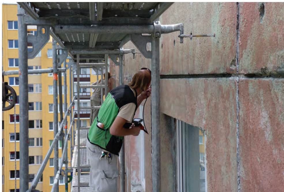
Fot. 97. Przeglądanie obiektu endoskopem z rusztowań. W razie odnalezienia lęgów ptaków lub kryjówek nietoperzy należy zmodyfikować harmonogram prac, co może oznaczać dodatkowe koszty dla wykonawcy (DZ)
