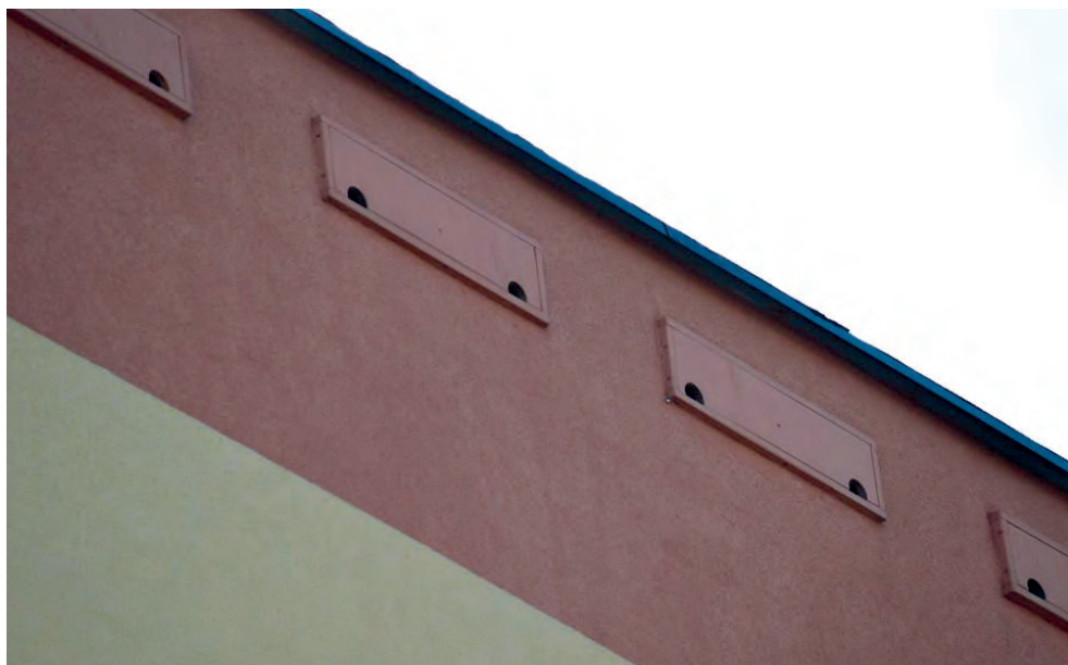
Fot. 106. Montowanie skrzynek podtynkowo, na wysokości stropodachu niweluje potencjalne oddziaływanie mostków termicznych na właściwości cieplne budynku (AT)
