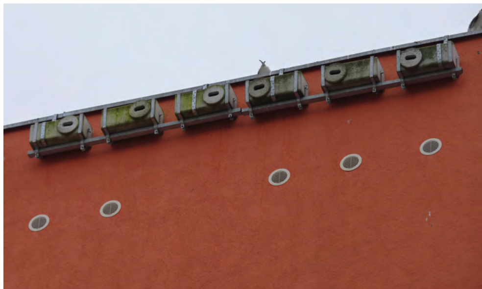
Fot. 108. Skrzynki dla jerzyków wykonane z trocinobetonu i zawieszane na stelażu (DZ)
