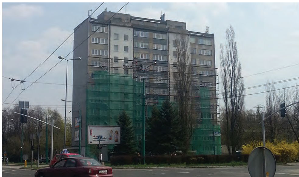
Fot. 135. Remontowany blok (DC)
